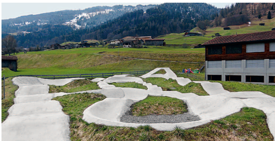
Damit die Fahrt spannend bleibt, verfügen Pumptracks – wie hier als Teil des Pausenplatzes des Schulhauses Jenaz – nebst Wellen und Kurven über Abzweiger und Übergänge.
